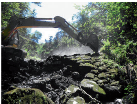
Destruction du seuil de Chelles Basse à la pelle mécanique. Juin 2010
