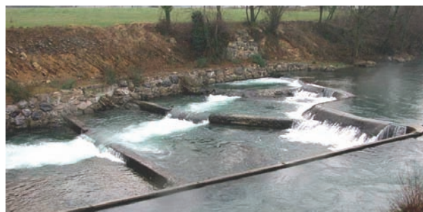
Photographie 13 : Prébarrages Gurmençon (64) - rivière Gave d'Aspe (GHAAPPE)
