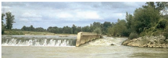
Photographie 20 : Rampe de Toulouzette (40) – rivière Adour (GHAAPPE)
