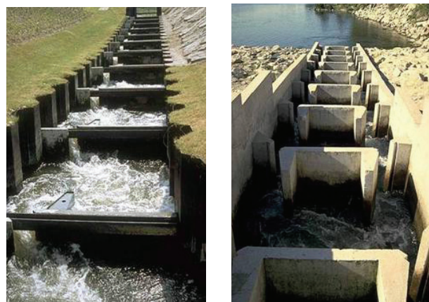
Photographie 8 : Passe à fentes verticales Méricourt (78) - rivière Seine et passe à fentes verticales Bonicelli (30) - rivière Gardon (GHAAPPE)
