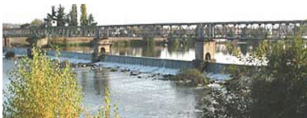
Figure 28 : Vue du barrage de Roanne- Loire
