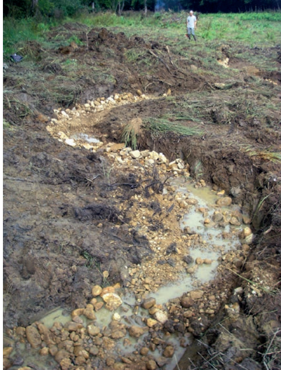
La fin des travaux en septembre 2011.
