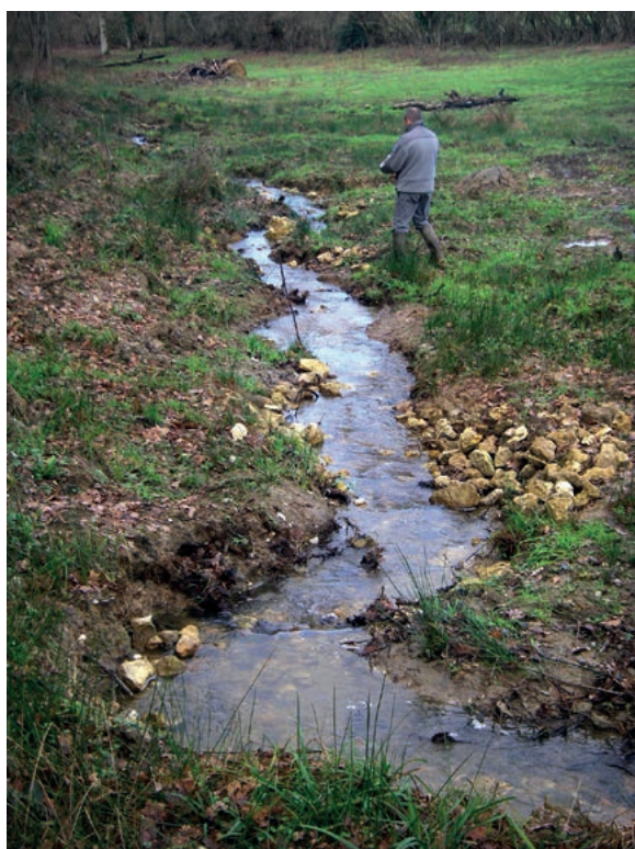
La Rivaille, quelques mois après les travaux en janvier 2012
