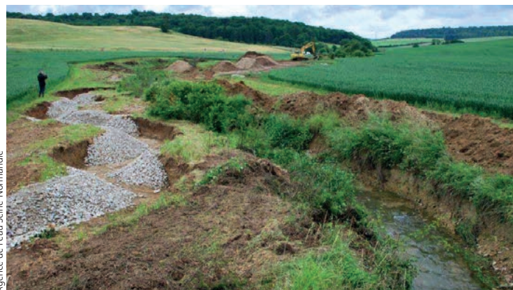
L'ancien lit de la Pisancelle et le nouveau lit méandriforme en 2013.
