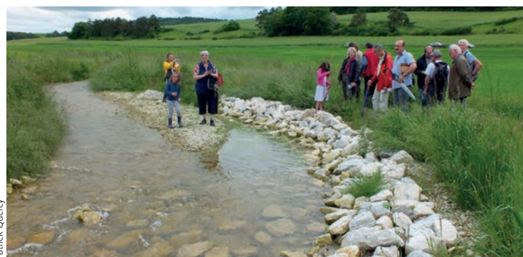
Les matériaux grossiers en rive convexe de la Pisancelle, trois ans après les travaux en 2016.
