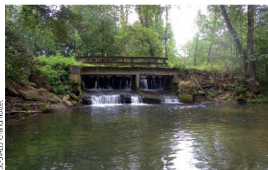
L'ouvrage de la scierie du Fourneau sur le Rongeant en 2011.
