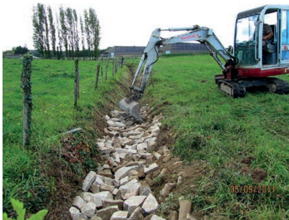
Rehaussement du lit du cours d'eau : positionnement de l'armature avec des blocs de granit à l'aide d'une mini-pelle, en septembre 2011
