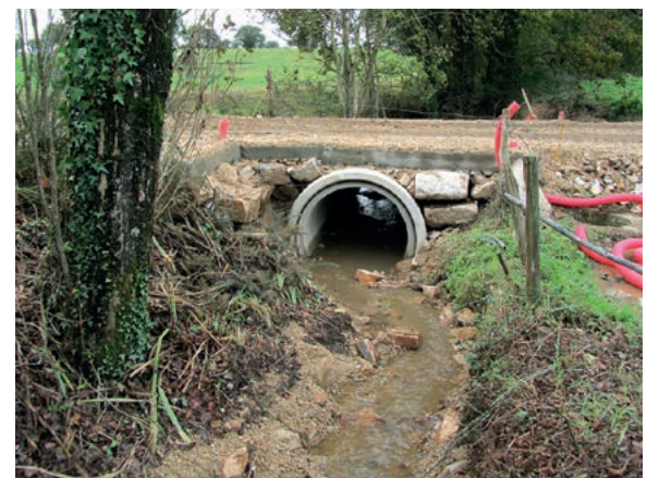
Remplacement de buse.
