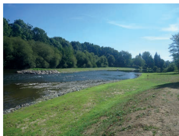
Le site de Maisons-Rouges après travaux en 2014.
