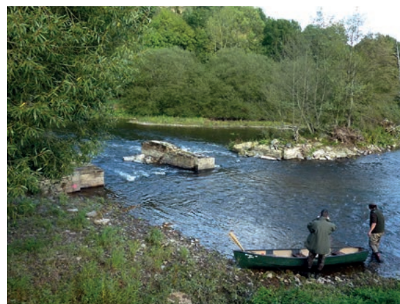
Le site de Maisons-Rouges avant travaux en 2012.
