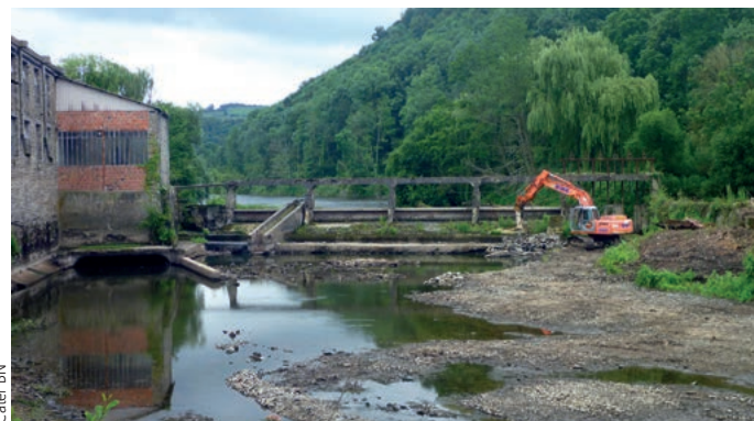
Le barrage de l'Enfernay avant travaux, vu depuis l'aval en 2012.
