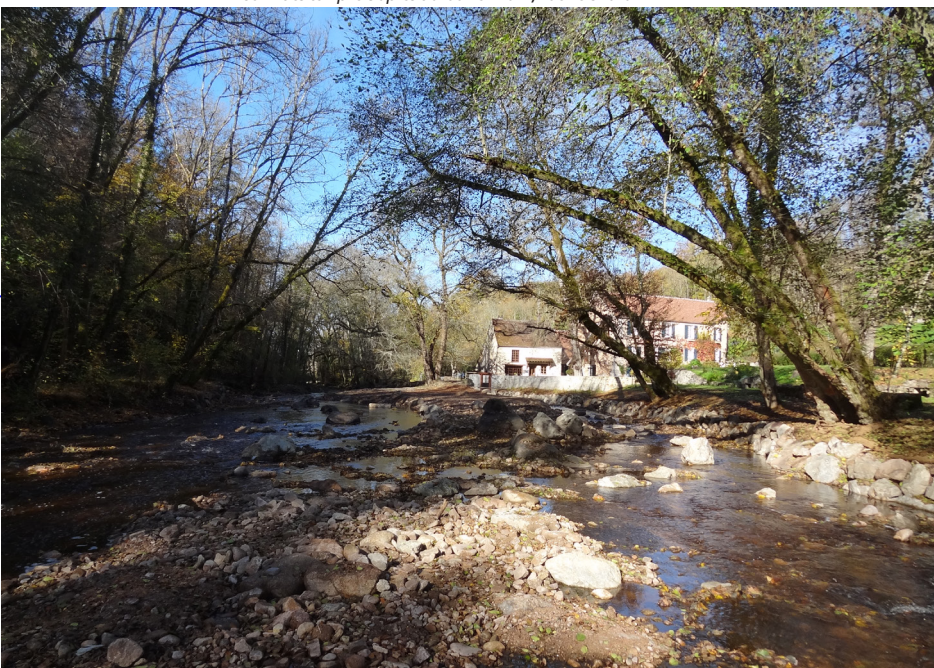
Moulin des templiers après travaux en 2017, vue vers l'aval
