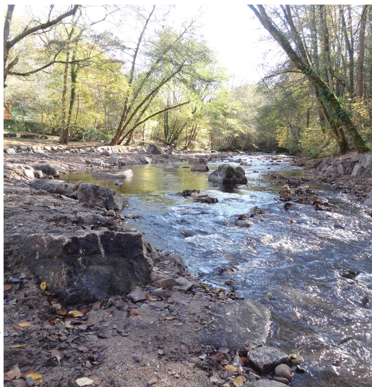
Vue vers l'amont après travaux en 2017, au niveau du seuil effacé
