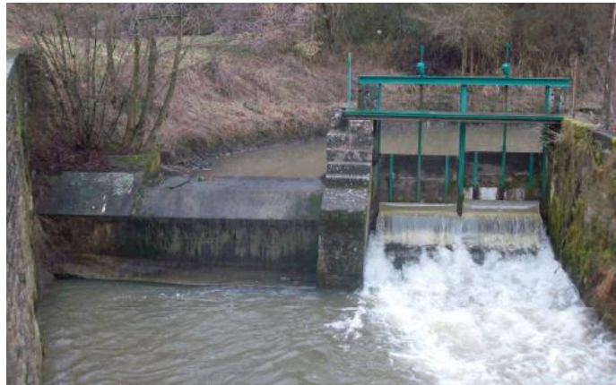
Ouverture d'un vannage (© J. Bouchard, OFB). A noter que, sur cet exemple, l'ouvrage semble toujours impossible à franchir pour des poissons en montaison.
