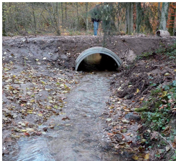
Remplacement de l'ancienne buse afin de la rendre franchissable. Novembre 2010.
