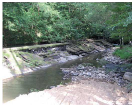
Le barrage du Martinet, avant travaux en 2007.
