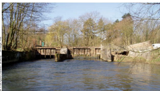
Ouvrage d'Avot-Vallée avant démantèlement, situé au niveau de la commune de Blendecques
