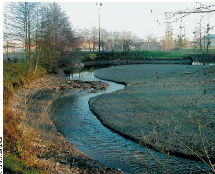
La cuvette de la retenue après les travaux d'abaissement de l'ouvrage de retenue. Le cours d'eau retrouve naturellement un chenal d'écoulement sinueux - 2004
