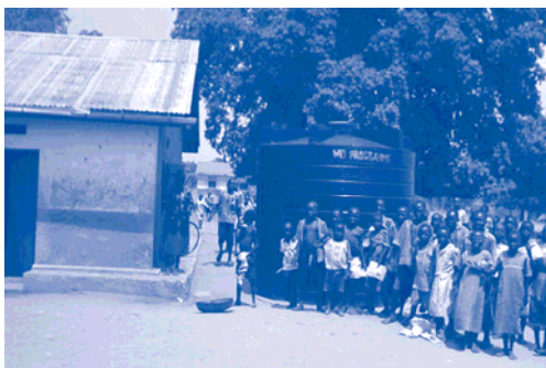
Figure 51 : Défaut de conception d'une installation (entrée de la cuve d'eau de pluie plus haute que la gouttière) (source : Thomas et Martison., 2007, p. 126)
