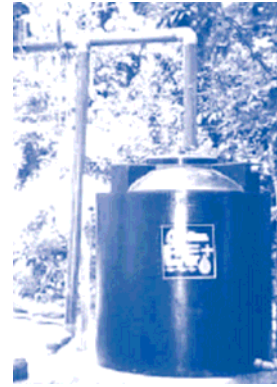
Figure 53 : Diverteur de premier flot (source : T. Ariyananda in Thomas et Martison, 2007, p. 113)
