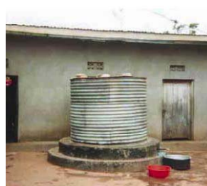
Figure 48 : Cuve en tôle (drum tank) (source : D. Rees)
