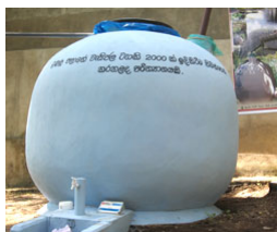
Réservoir d'eau de pluie achevé.
