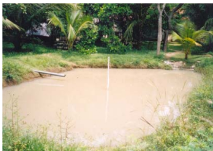
Figure 34 : Exemple de bassin de récupération des eaux de pluie de ruissellement, en zone sèche, appelé « Pathahas » (Weeraratna C.S., 2006).
