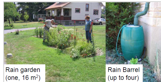
Figure 17 : Dispositifs installés dans le cadre du projet pilote « The Shepherd Creek expérience », les trop-plein des récupérateur d'eau de pluie étant dirigé généralement vers le jardin (source : Shuster et al., 2010).
