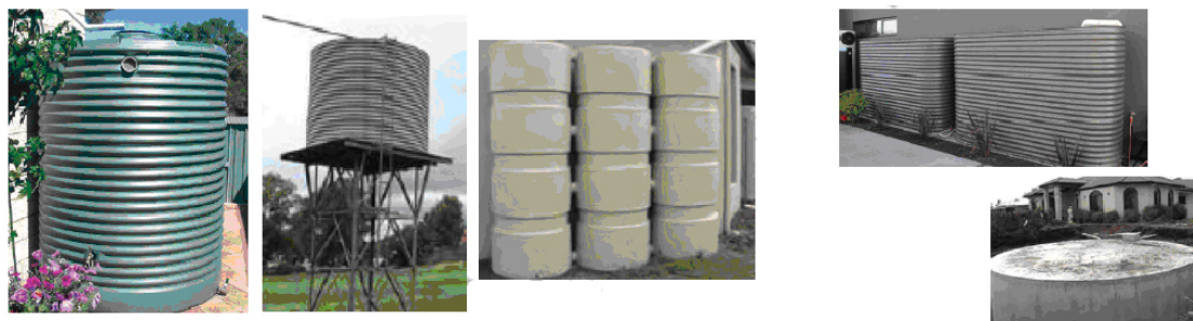
Figure 24 : Exemples de cuves d'eau de pluie couramment utilisées (source : de gauche à droite, de haut en bas : Government of Western Australia, Queensland Building Service Authority x 3, Aquaplate).
