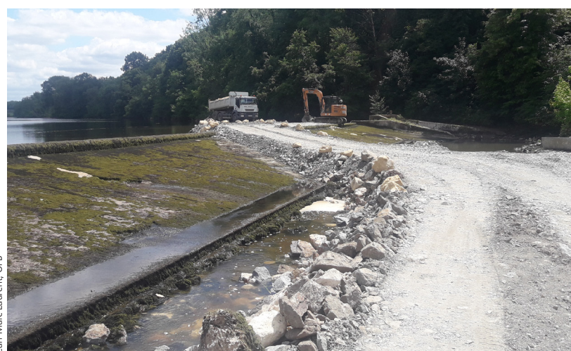
Progression des engins de chantiers lors des travaux de la passe à macrorugosité en rive gauche en juin 2020.
