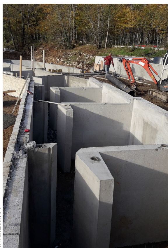
Finalisation de la passe à bassin successifs en novembre 2020.
