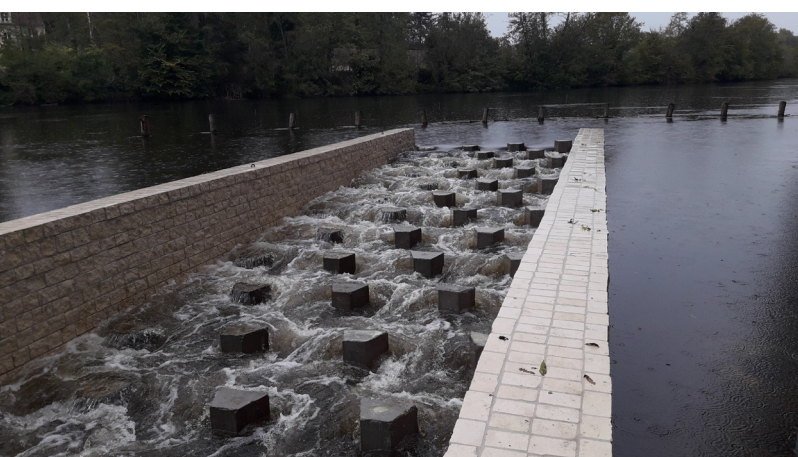
Finalisation de la passe à macrorugosité en rive gauche en septembre 2020, et mise en eau en octobre 2020.
