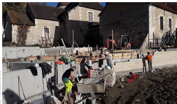
La passe à bassin successifs a été ornée de parements en pierres de Chauvigny (calcaire non sensible au gel) pour respecter l'aspect patrimonial du site en octobre 2020.
