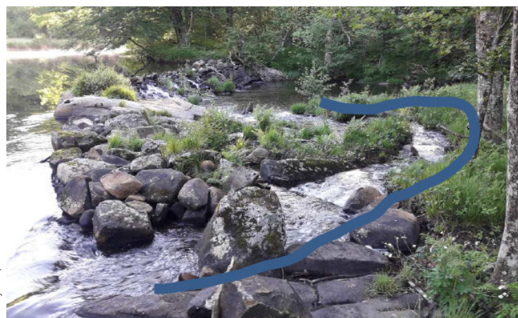
Rivière de contournement naturelle après travaux
