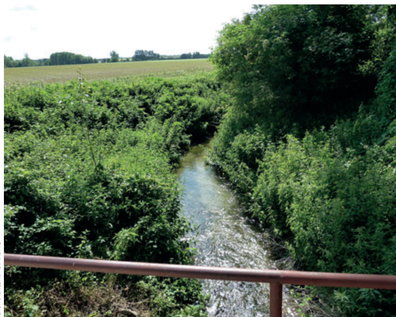
Environ 150 m en amont du seuil, trois ans après travaux. Juin 2011
